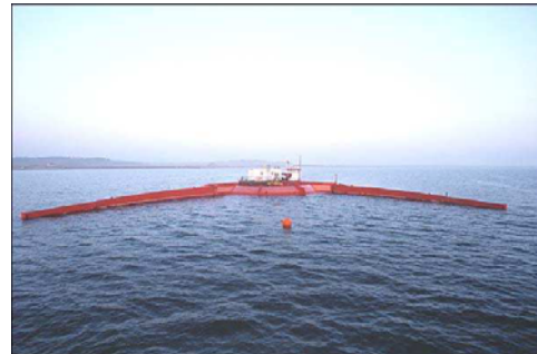
Prototipo Wave Dragon Nissum Bredning (escala 1/5.2 del Atlántico)
