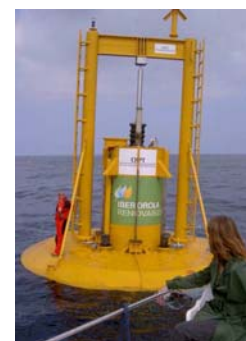
Boya OPT instalada en aguas de Santoña (Cantabria). Potencia: 40 Kw
